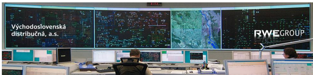
Dispečerské stredisko v plnej prevádzke
