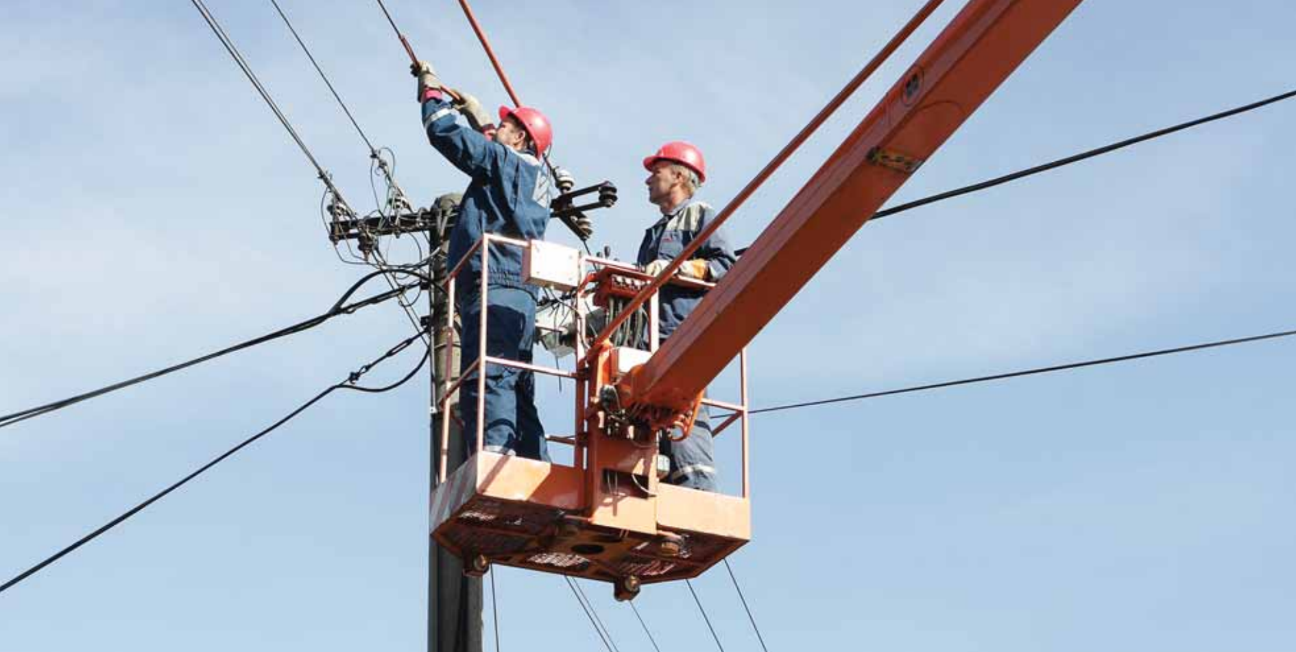
Príprava pracoviska pre opravu preponky metódou PPN (práce pod napätím).
