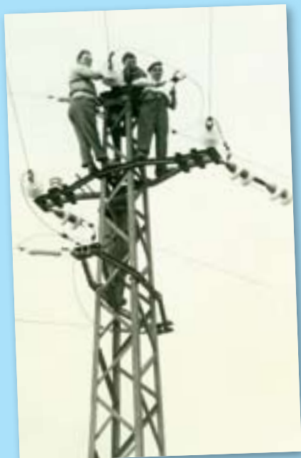
Zváranie vodičov na elektrickom stĺpe
